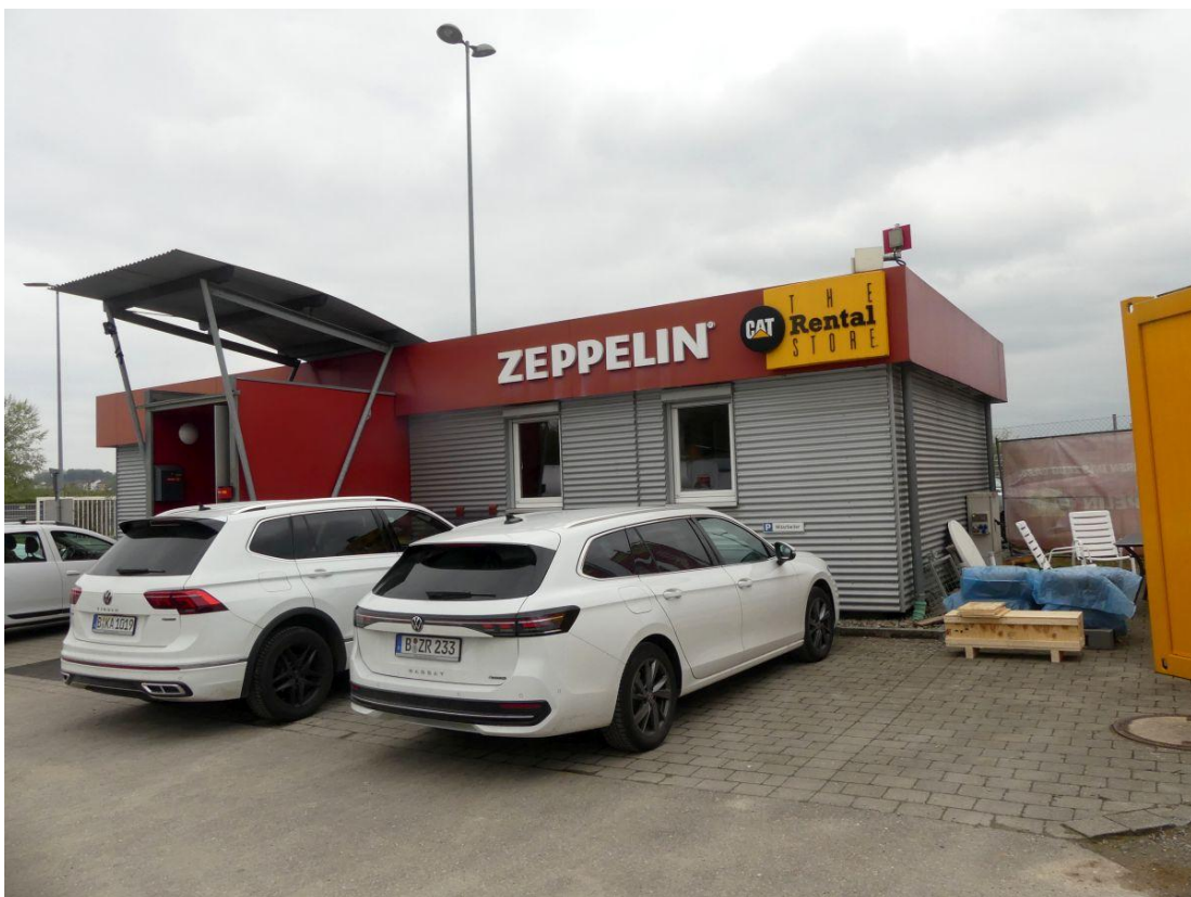
Abbildung 12: Bürogebäude der Zeppelin Rental GmbH.
