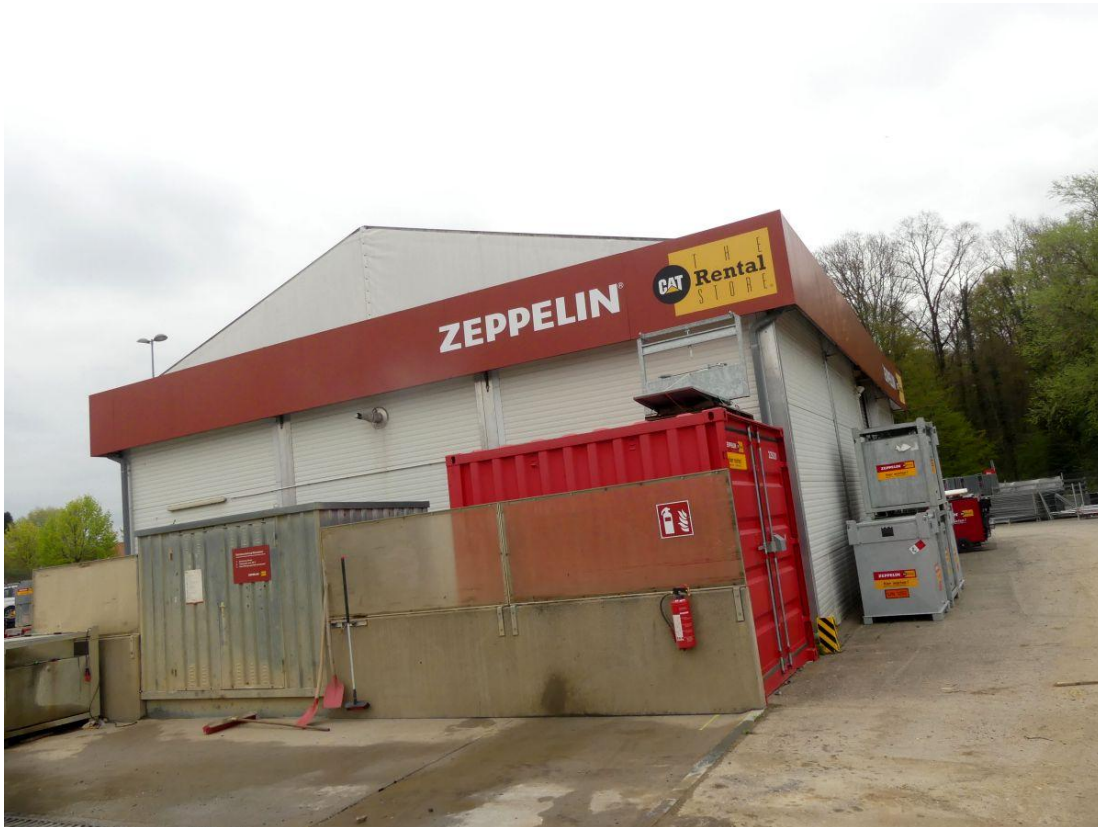
Abbildung 11: Lagerhalle der Zeppelin Rental GmbH.
