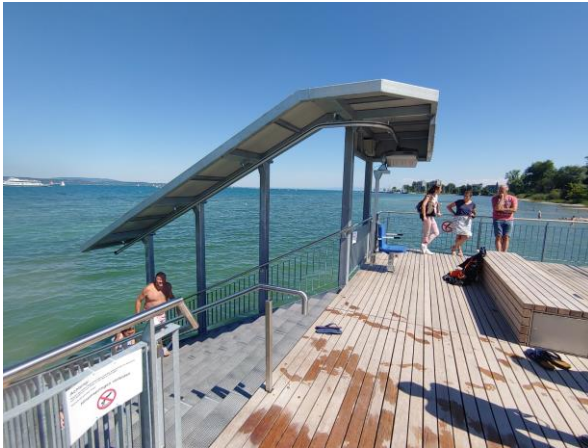
Abb. 22: Beispiel Lift und breiter Treppenzugang am Steg im Strandbad Hörnli, Kreuzlingen.
