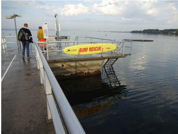
Der Stegkopf. Hier soll der barrierefreie Lift installiert werden.
