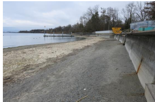
Blick in die andere Richtung (Wasserwerk)
