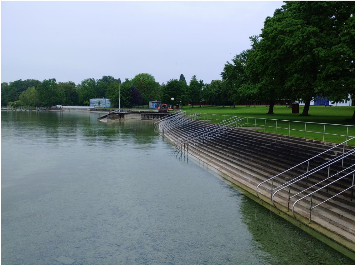
Abb. 14: Das hat verbaute Ufer inklusive der großen Treppenanlage wird vollständig abgebrochen.
