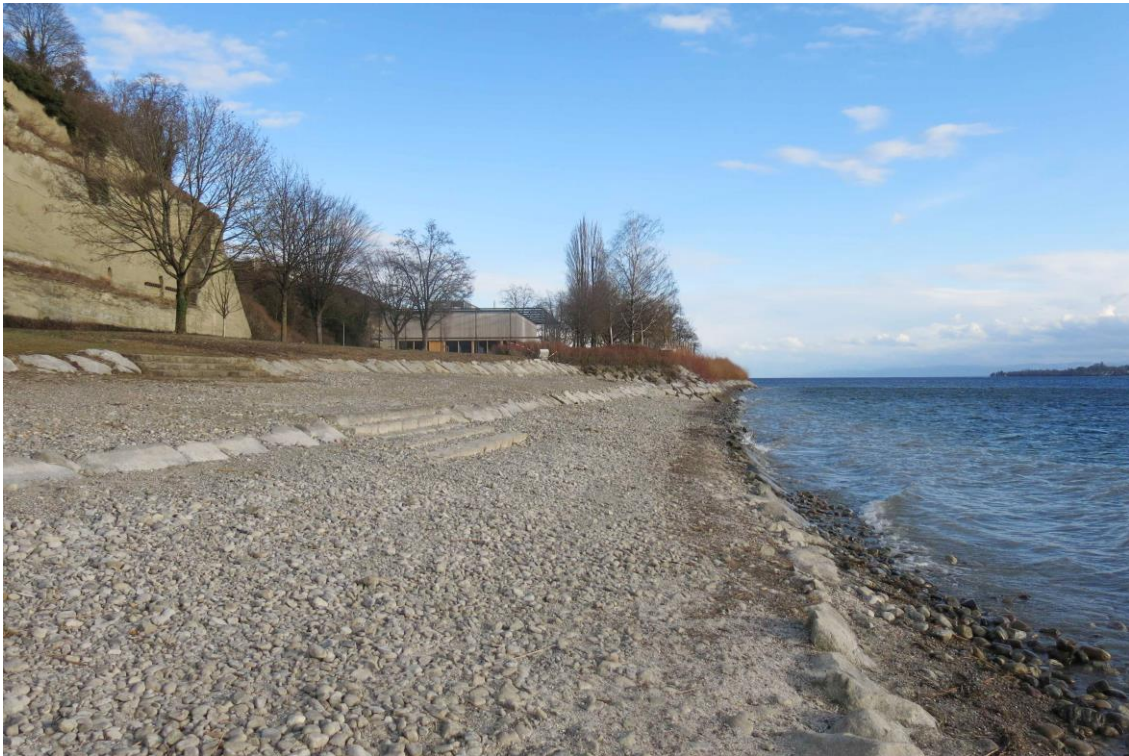
Abb. 13: Referenzbeispiel Uferterrassen im Uferpark Überlingen mit integrierten Treppenanlagen
