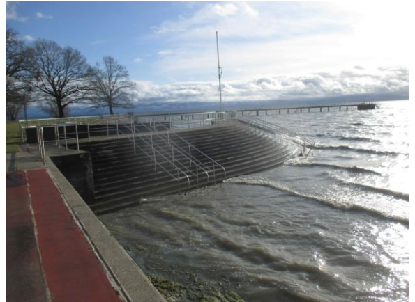
Blick auf Hafenanlage
