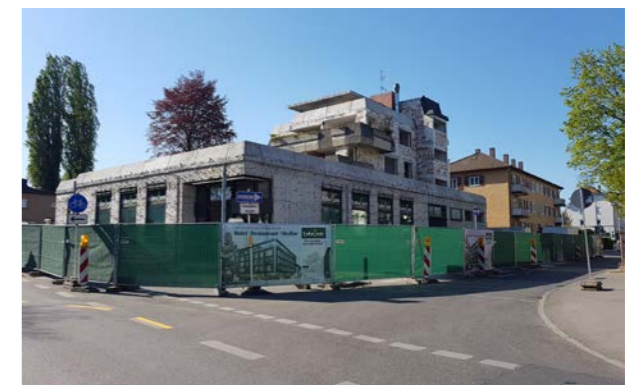
Lukullum Baustelle, April 2020
