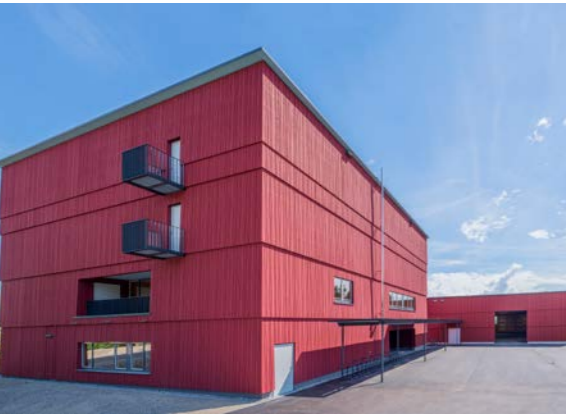
Fundusgebäude mit Fahrzeughalle (Seehasenfundus)
