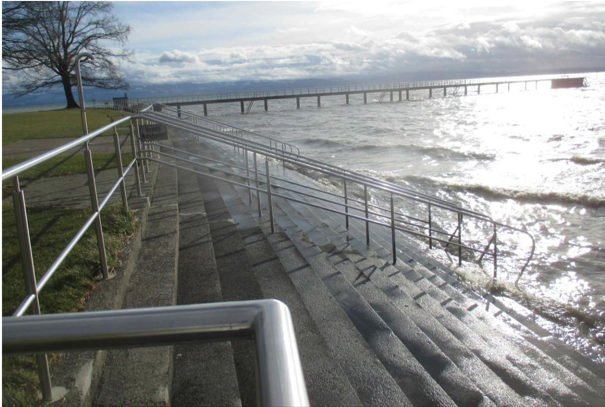
Blick von Nord nach Süd (Richtung Steg) auf die Treppenanlage im Uferbereich.
