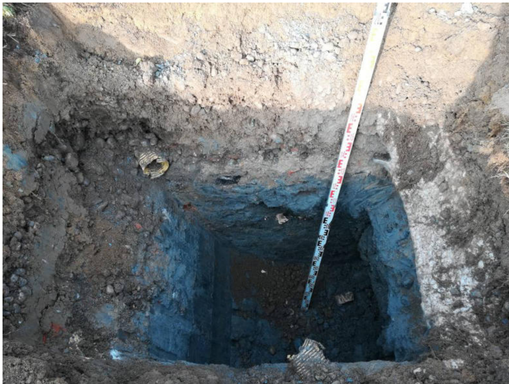
Schürfgrube SG6, BV Neubau KITA Habakuk
