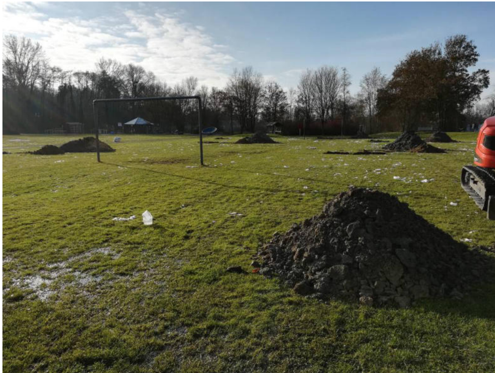
Übersicht Baufeld BV Neubau KITA Habakuk, Kastanienweg, Friedrichshafen
