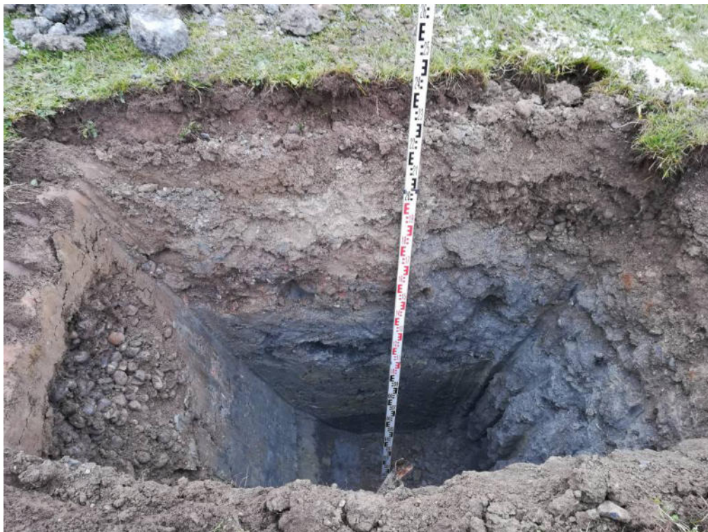
Schürfgrube SG1, BV Neubau KITA Habakuk
