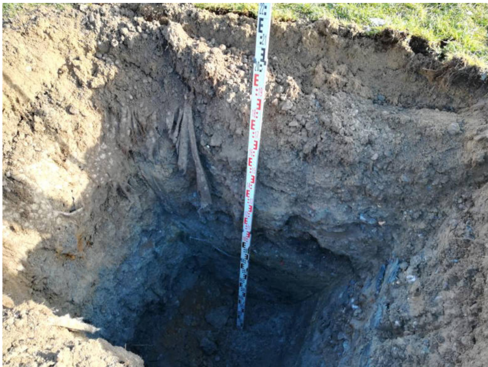
Schürfgrube SG7, BV Neubau KITA Habakuk
