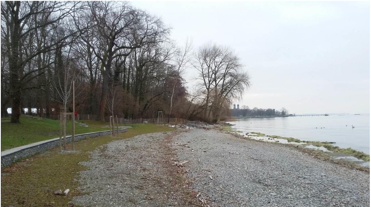
Renaturierter Uferbereich mit Gabionensitzmauer, Blick nach Osten
