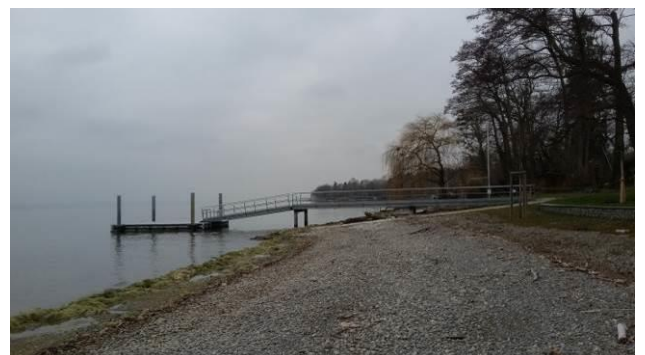
Foto 19: Ufer mit Slipanlage und Steg
