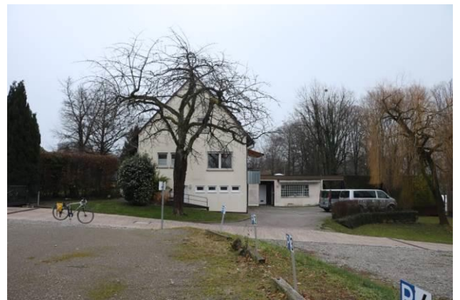
Foto 4: Bestandsgebäude mit Waschräumen
