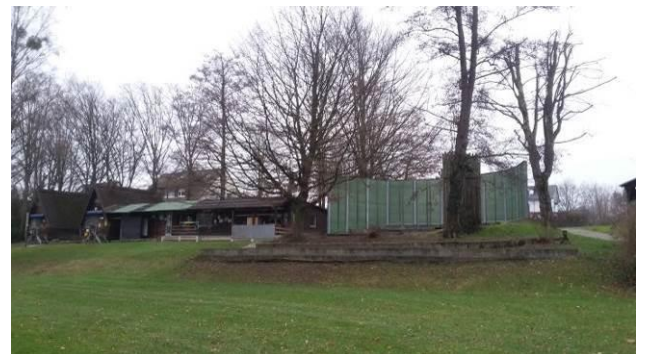
Foto 11: Mars-Arena und Gebäude vom Bolzplatz aus gesehen.
