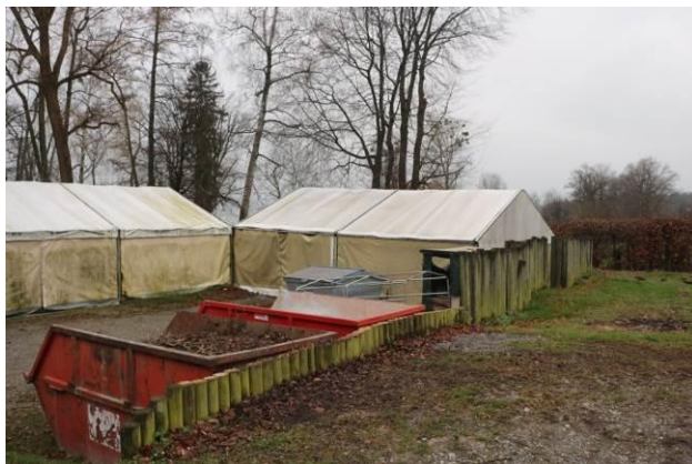
Foto 5: „Garagenzelt“ und Lagerflächen
