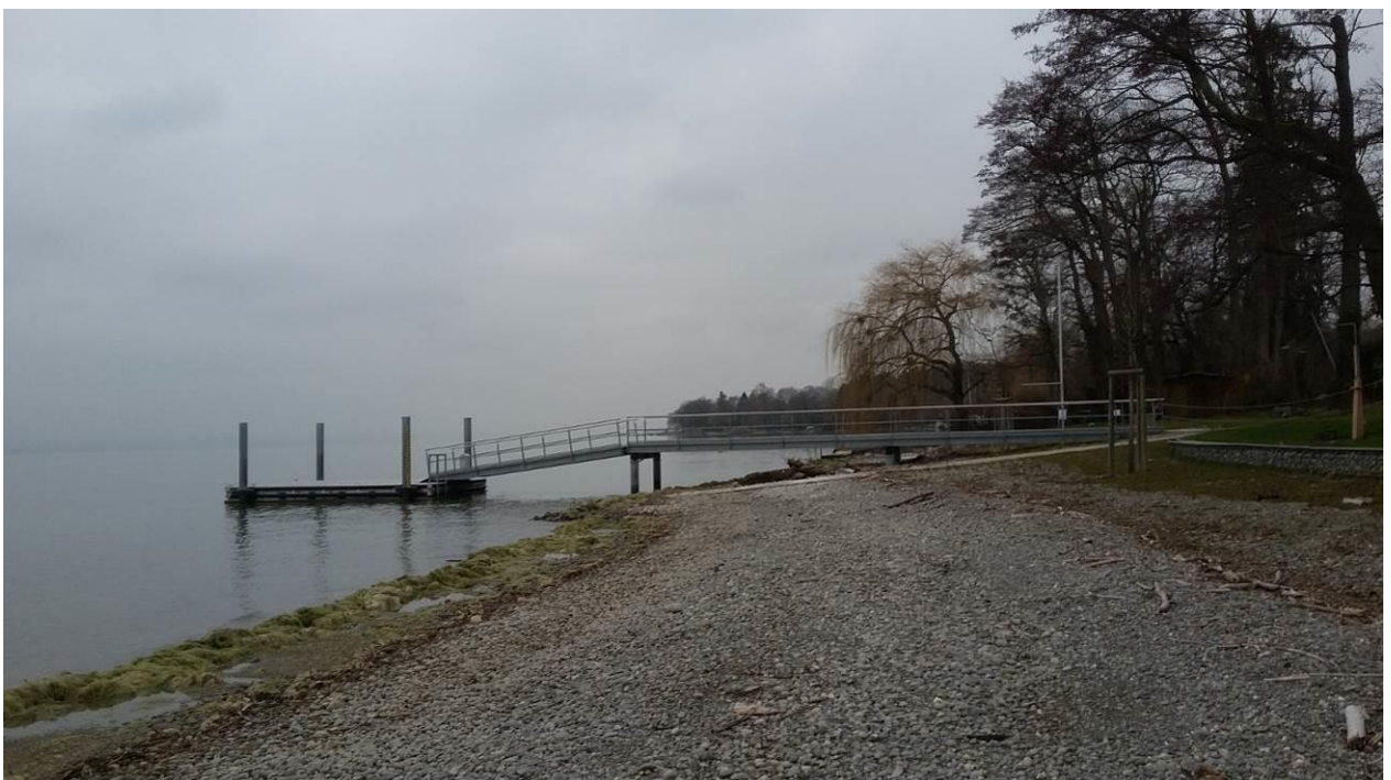
Renaturierter Uferbereich mit neuem Steg und Slipanlage, Blick nach Westen
