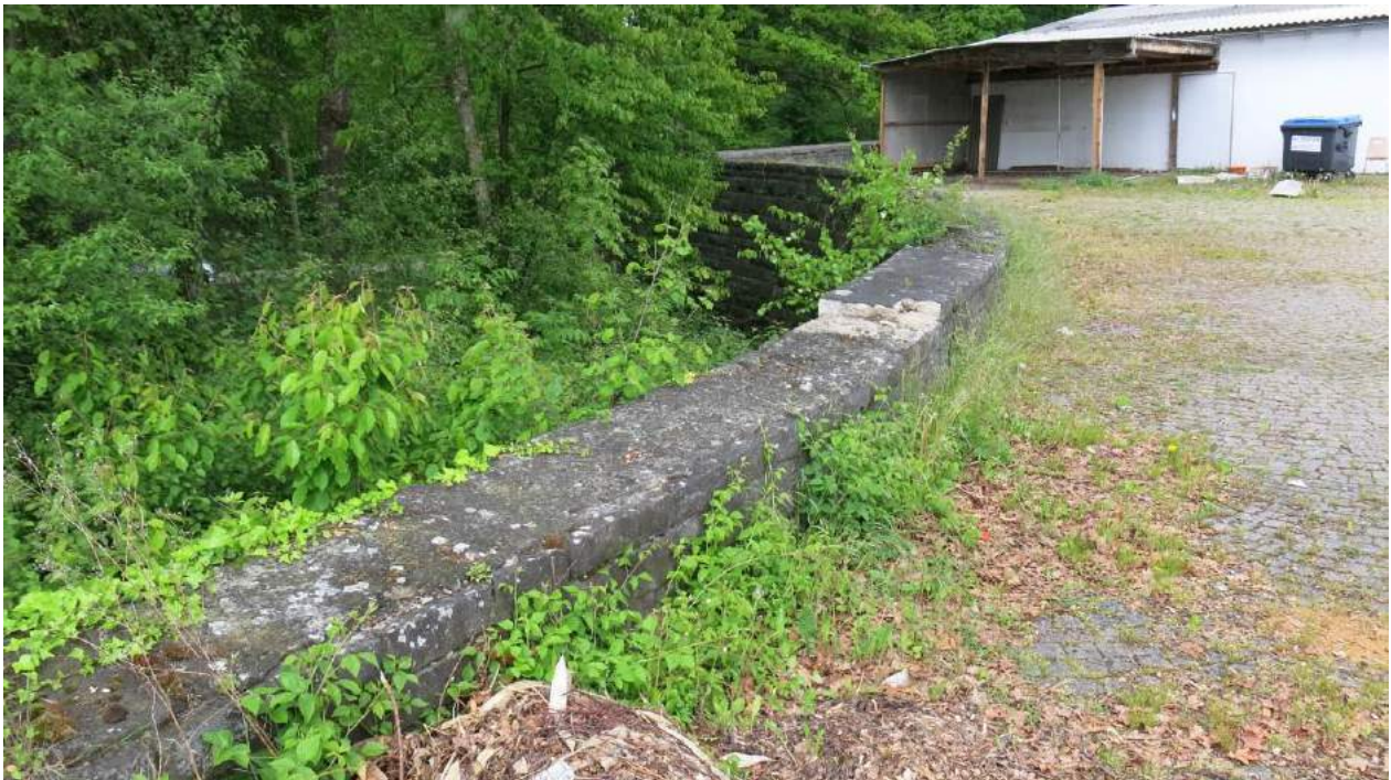
Foto 1 + 2: Areal Fallenbrunnen 16 vor den Rückbaumaßnahmen. Im Bereich der zum Abriss vorgesehenen Mauer dienen die Mauerritzen als Verstecke (Fortpflanzungs- und Ruhestätte), Jagdhabitat sind die angrenzenden besonnten Bereiche mit Ruderalvegetation und ggf. der an-grenzende Gehölzbestand.
