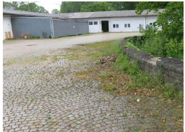
Foto 4 (05/2014): Gepflasterte Hoffläche und Lagerhalle vor Abriss und Entsigelung
